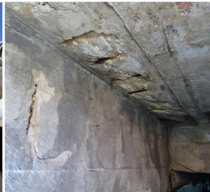
Es el primero y el más importante de los ensayos no destructivos. Consiste en la revisión detallada de las estructuras para detectar daños por acciones mecánicas, físicas, químicas, biológicas, corrosión del acero de refuerzo, falencias de tipo constructivo, entre otros.
